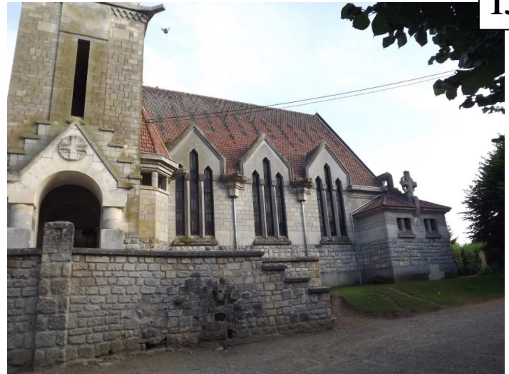
Mur gouttereau nord. (photos. Pauline Berthelot)
